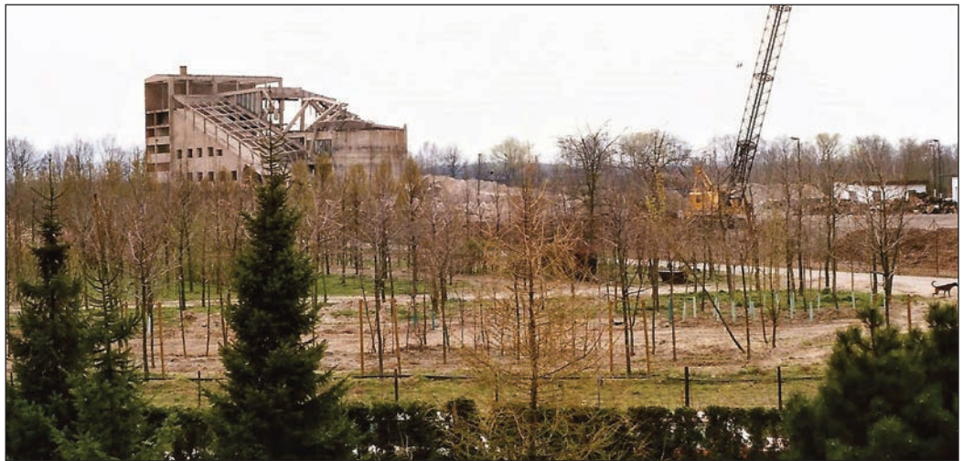
Bild vom Abriss des ehemaligen Sintersplittwerkes in der Blohmstraße im Jahre 1988.
