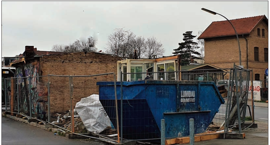
Ein Stück Lichtenrade weniger. Der Kiosk an der Bahntrasse ist nur noch Stein und Schutt. 100 Jahre stand der Kiosk hier an diesem Ort. Fotos/Repros: Heimann
